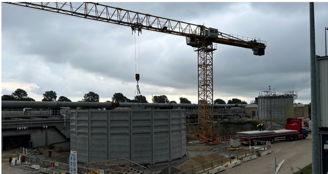
Elementer monteres på fordelerbypværk
