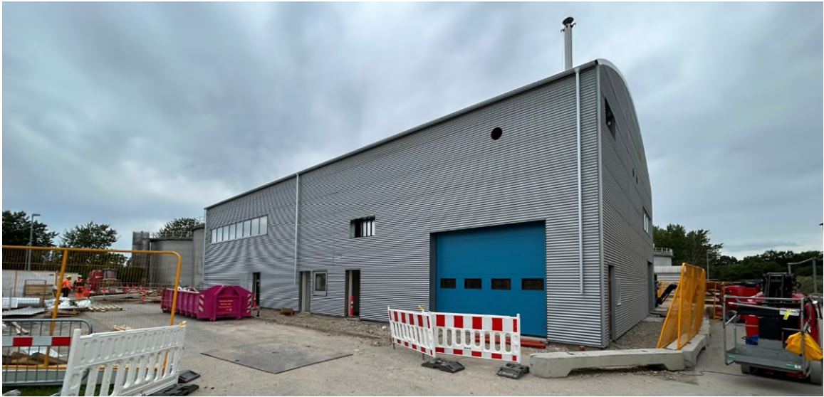
Bygning for det kommende THP-anlæg.
