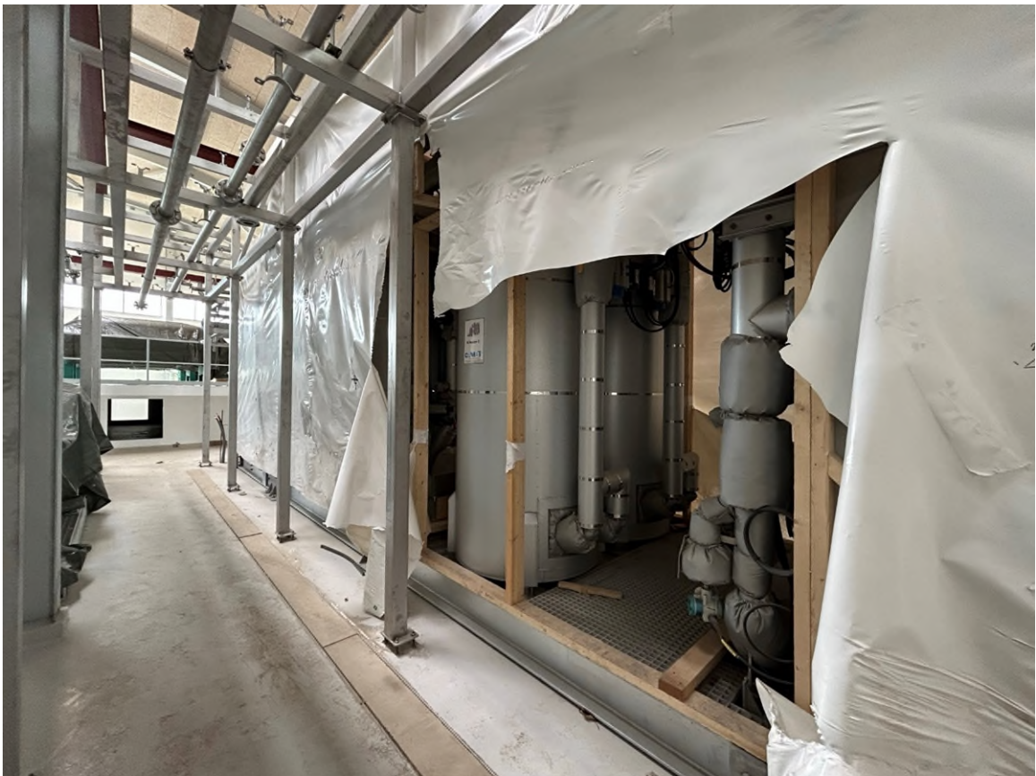
Komponenter til det kommende THP-anlæg.
