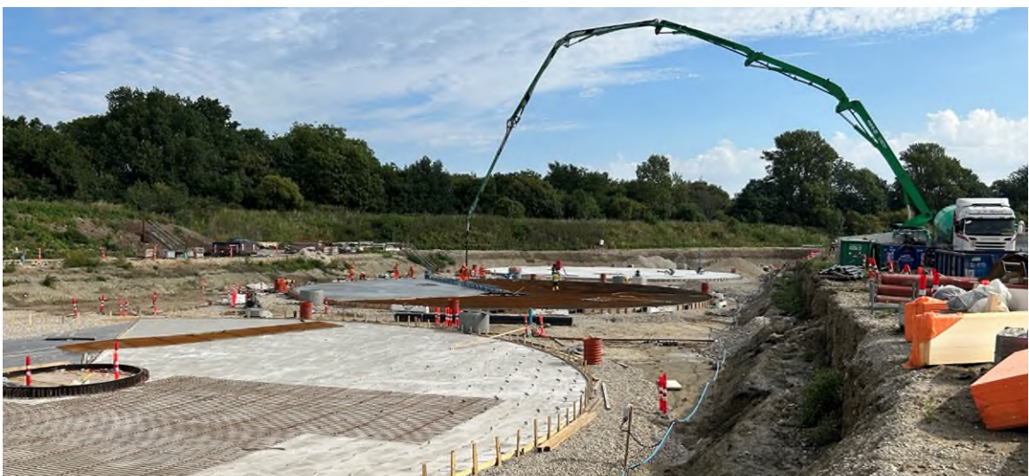
Støbning af bundplader til efterklaringstanke
