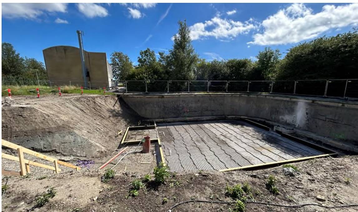
Udgravning til ny mellempumpestation, men den eksisterende i baggrunden.
