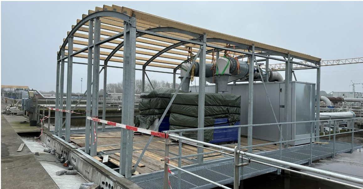
Et af de nye blæserhuser på Renseanlæg Damhusåen begynder at tage form
