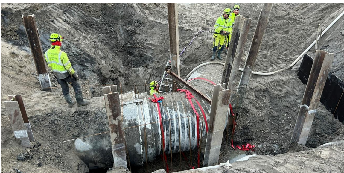
Den endelige sammenkobling af nyt og gammelt ø1600 rør, før omkringstøbning med beton
