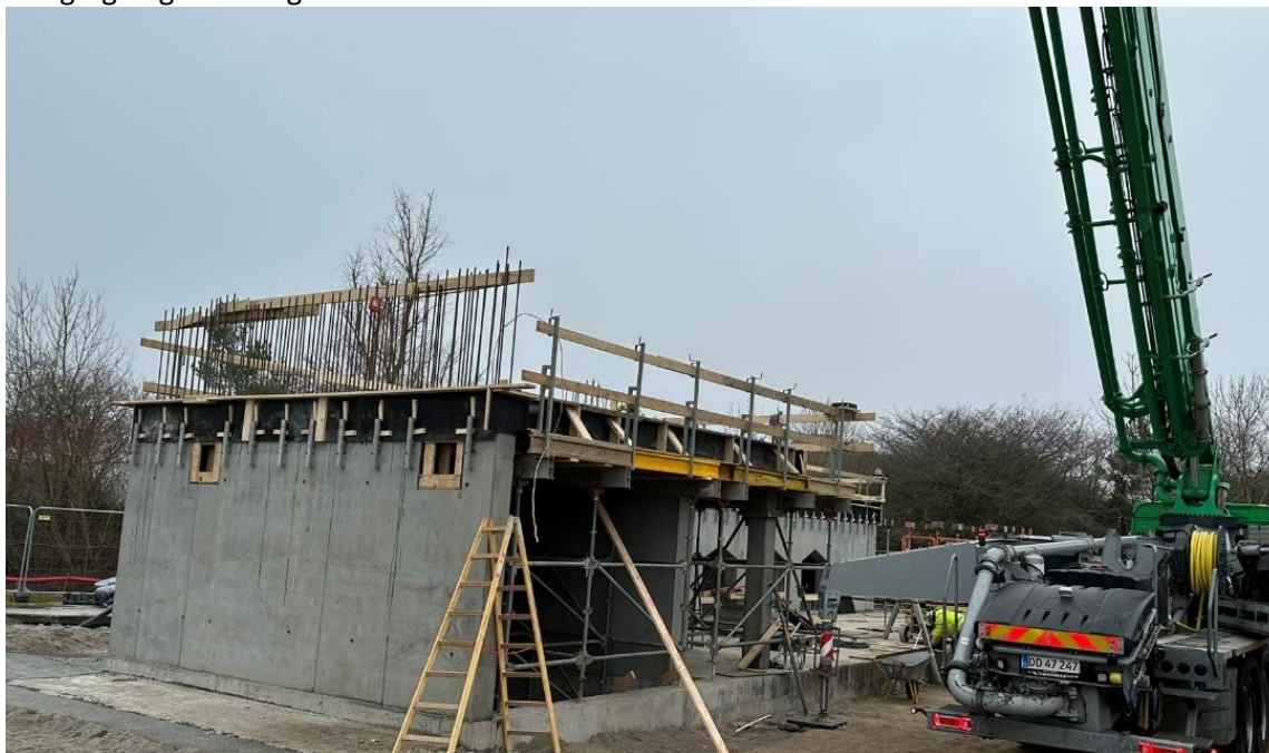
Støbning af den nye mellempumpestation er nu kommet over terræn
