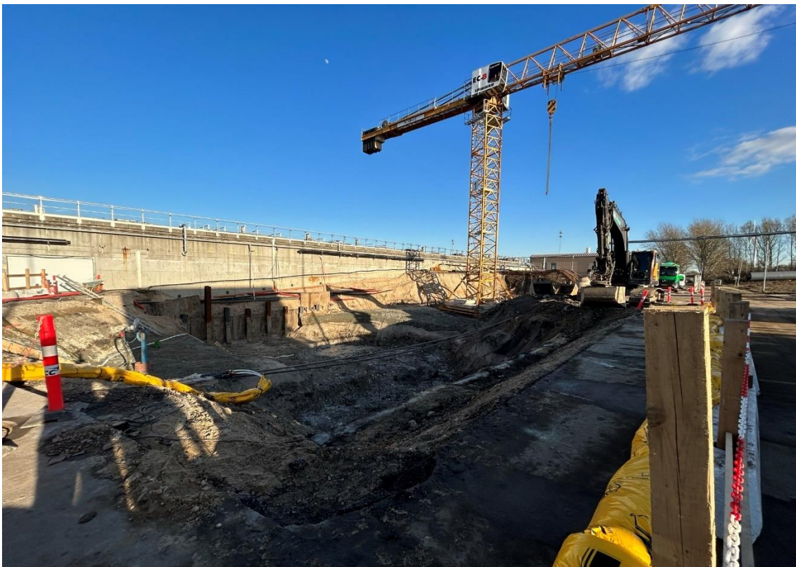
Udgravning til fordelerbygværk.
