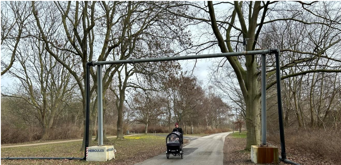
Rørføring på bl.a. Parkstien til håndtering af det oppumpede grundvand.
