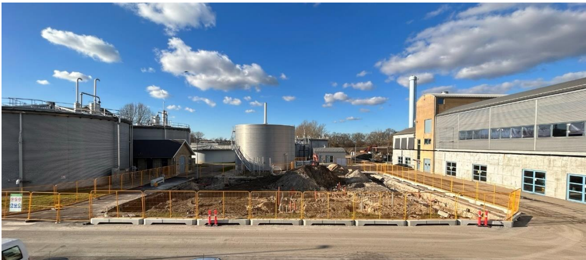
Byggepladsen for det kommende THP anlæg.
