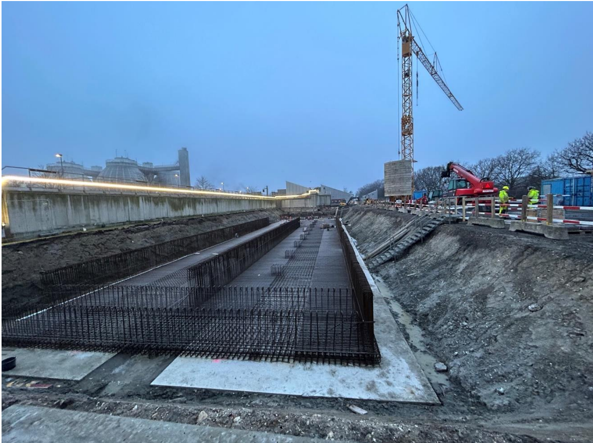
Udgravning og armering til det kommende sand- og fedtfang på Renseanlæg Avedøre.
