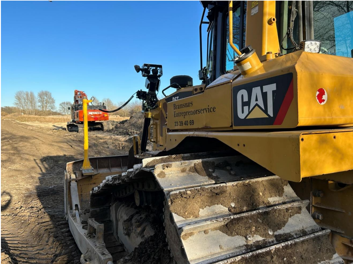
Et 11.000 m 2 stort område øst for renseanlægget er gjort klar til mellemdponering af godt 60.000 m 3 jord.
