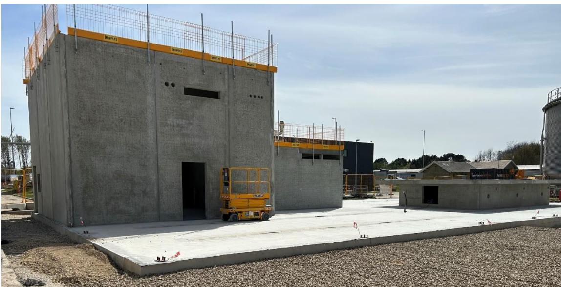
Fundament og bygning for det kommende THP-anlæg.
