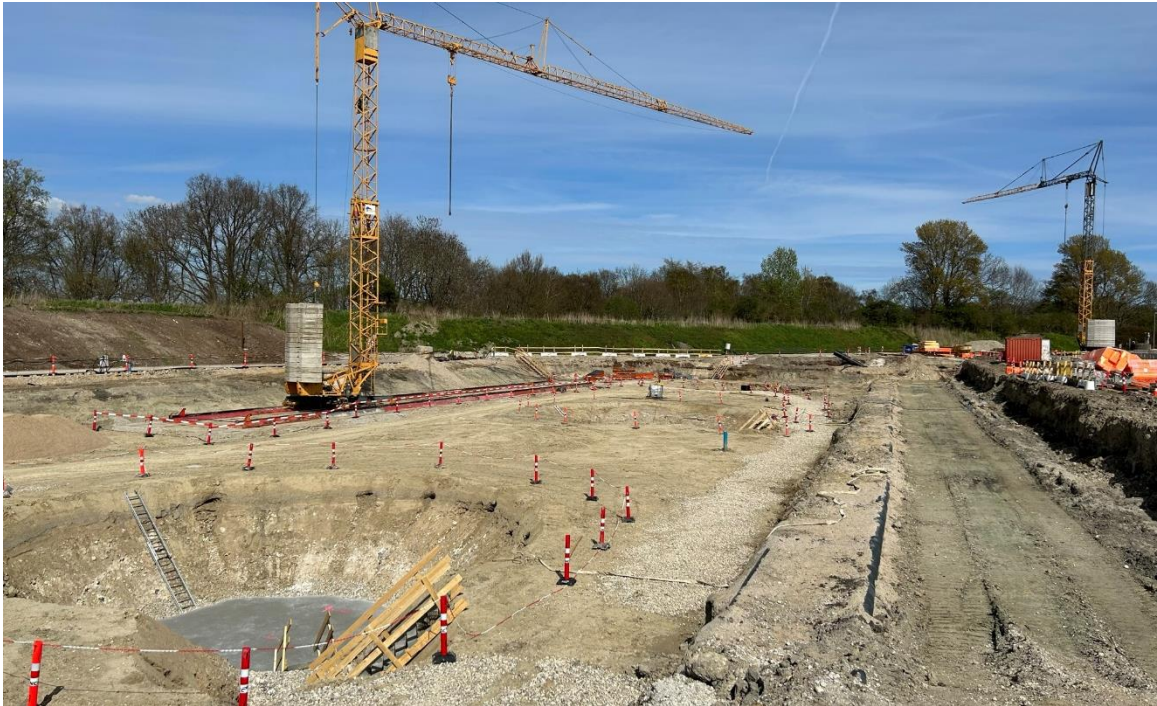
Udgravning til efterklaringstanke
