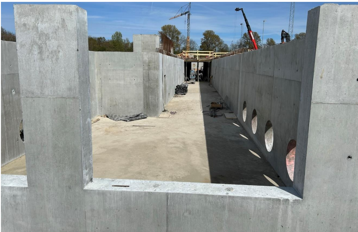
Ingeniørgangen – nu med støbte gulve og vægge
