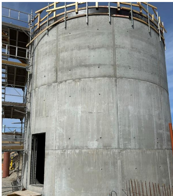
Støbning af rejecktandstank
